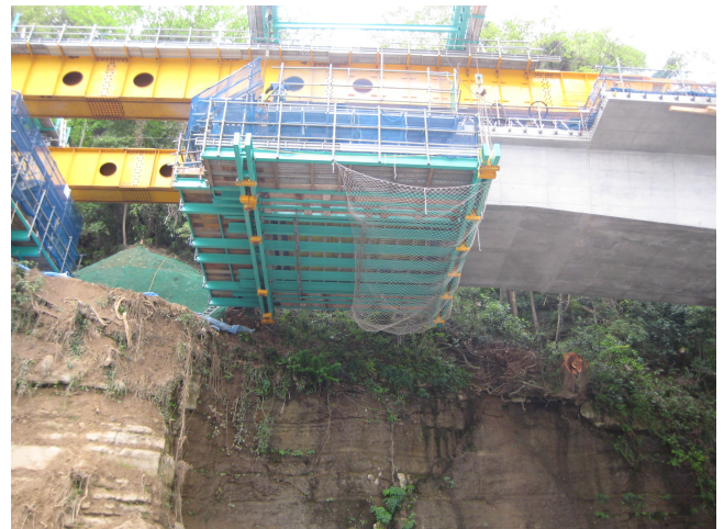
写真-3 コア断面での張出し架設
