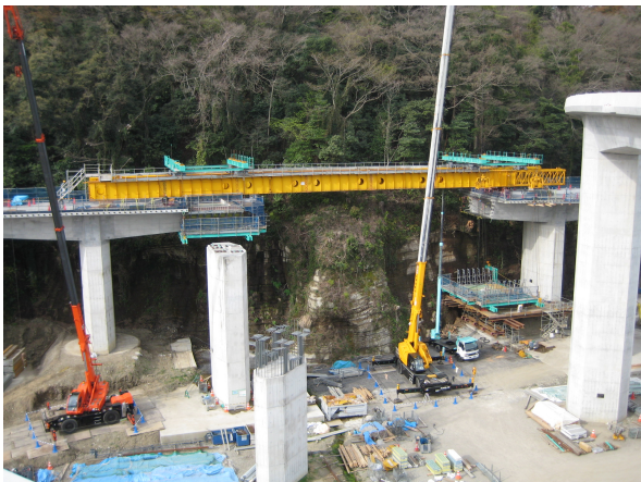
写真-1 架設状況
