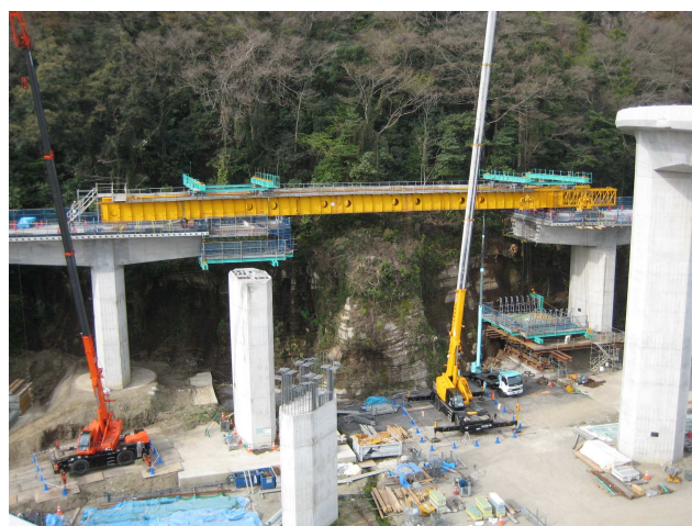
写真-1 架設状況
