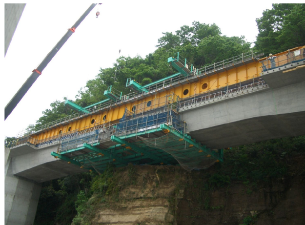
写真-8 コア断面での張出し架設 (3BL)
