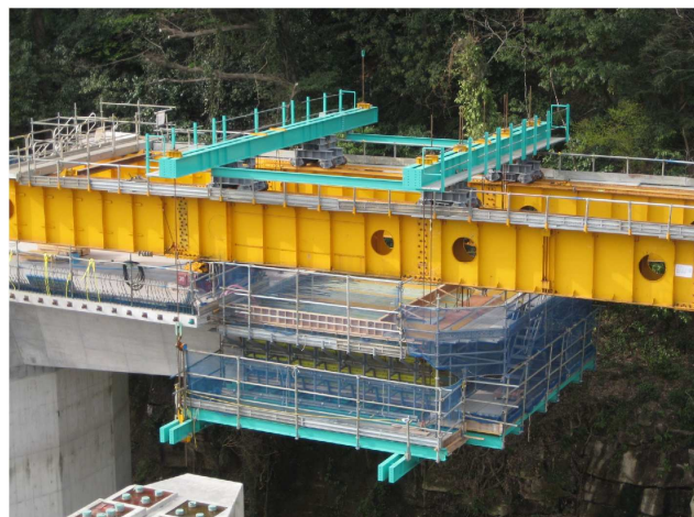
写真-6 移動作業車
