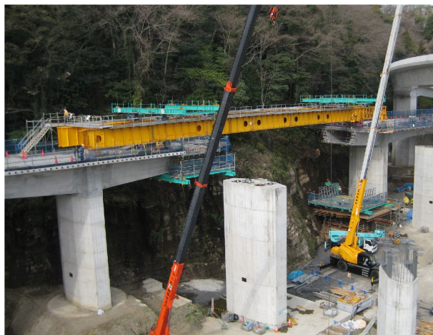
写真-5 張出し架設状況
