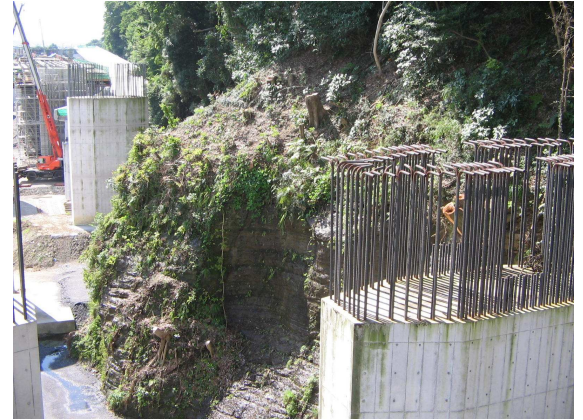
写真－2 崖部の迫り出し（施工前）
