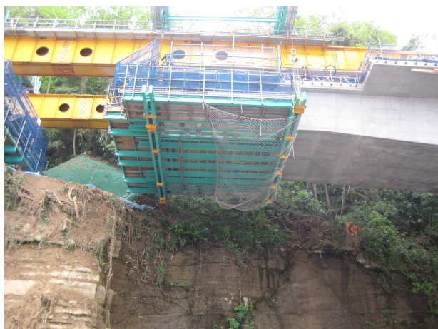
写真-7 コア断面での張出し架設 (2BL)
