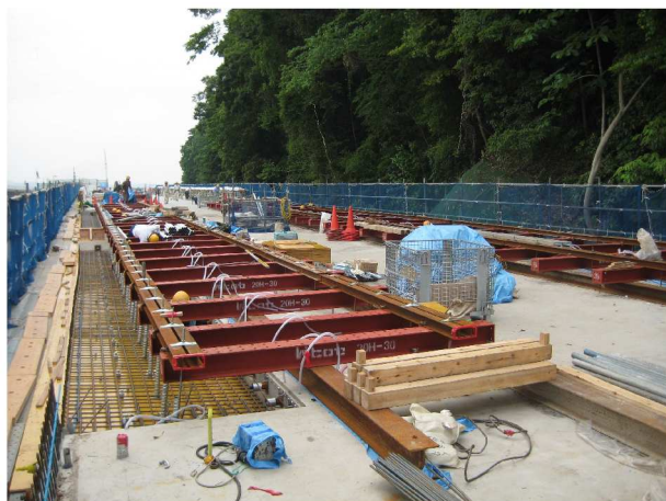
写真-11 張出し床版の施工
