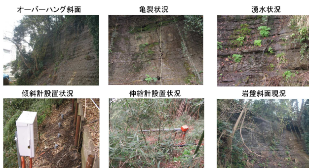
写真－4 崖部の現況調査（施工前）
