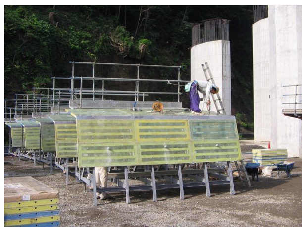
写真-10 型枠地組み状況
