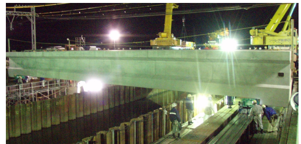
写真-3 横取り状況
