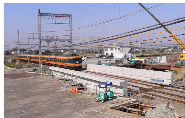
写真-4 架設完了
