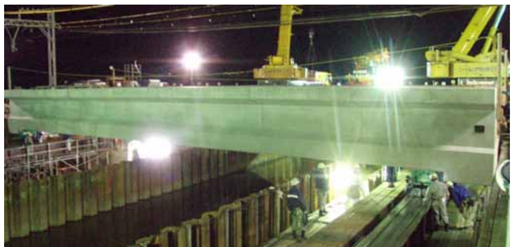
写真-8 本施工状況
