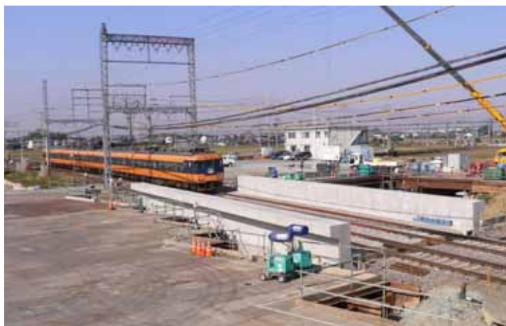
写真 - 1 架設完了後の富屋川橋梁
