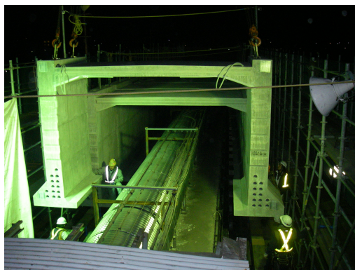
写真-3 セグメント架設状況
