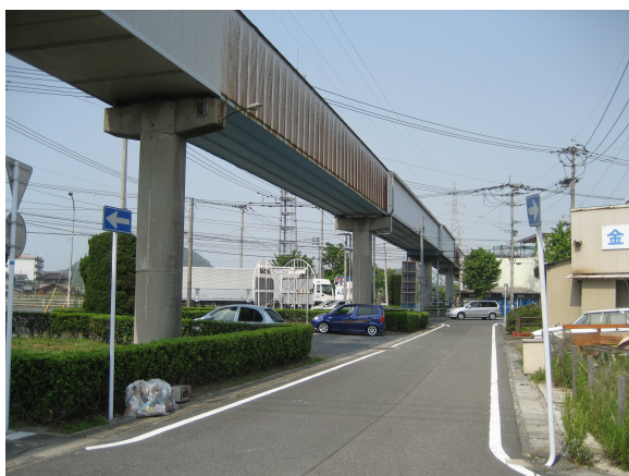
写真-1 施工前(鋼製トラス式)
