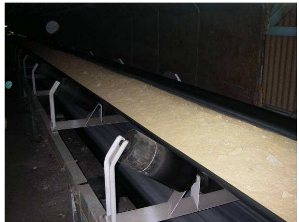
写真-2 ベルコン橋内部
