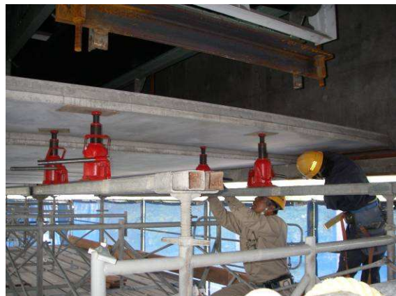
写真-22 PC板据え付け
