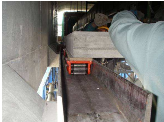
写真-20 PC板仮受け
