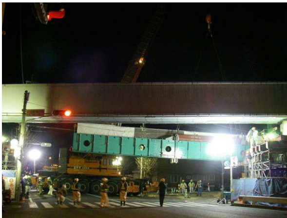
写真-3 架設桁設置状況 (南側)
