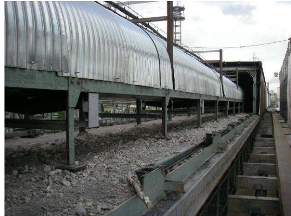
写真-6 既設橋本体解体
