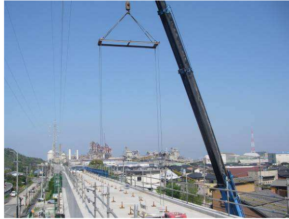
写真-18 PC板吊り上げ
