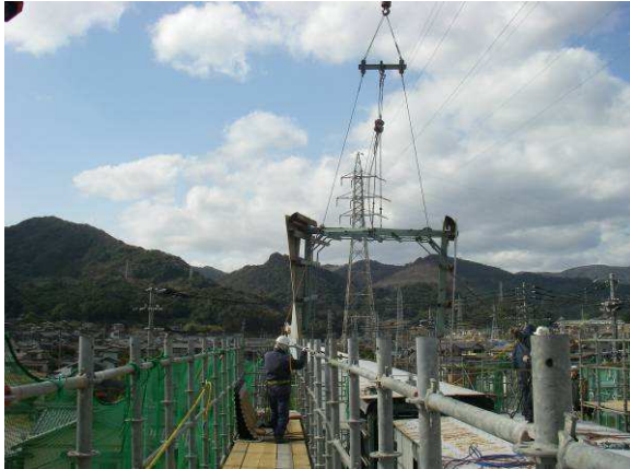
写真-5 既設橋本体解体
