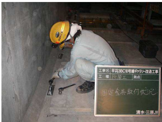
写真-23 PC板固定
