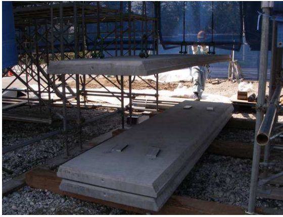
写真-17 PC板吊り上げ
