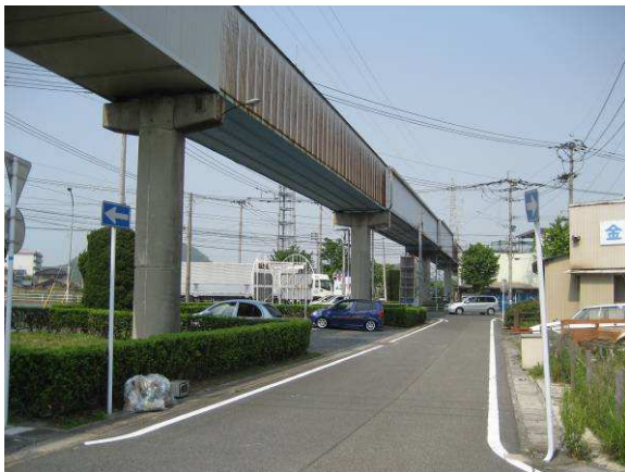
写真-1 着工前状況
