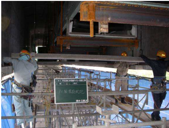
写真-19 PC板吊り上げ
