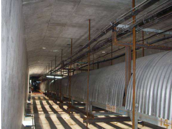
写真-15 ベルコン仮受け
