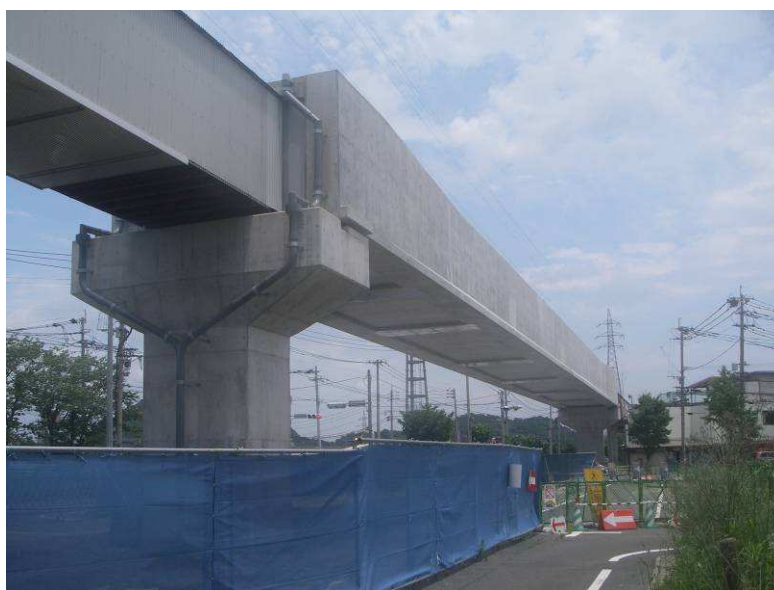
写真-25 施工完了
