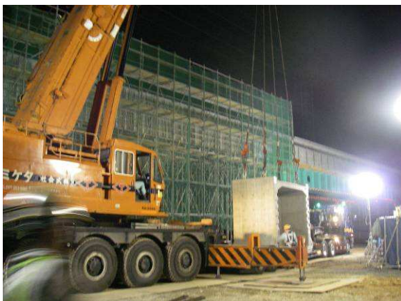
写真-7 セグメント桁搬入
