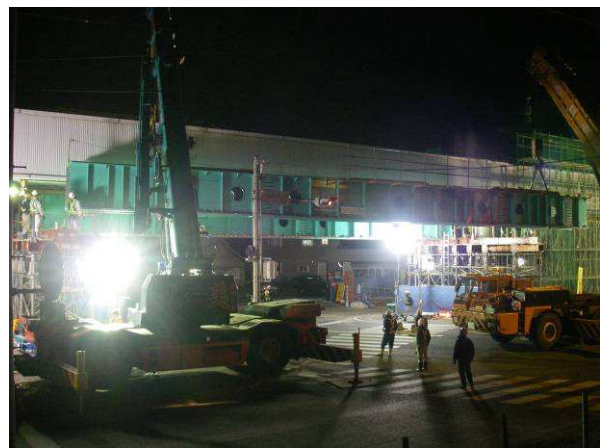
写真-4 架設桁設置状況 (高圧線側)
