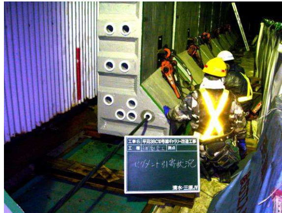
写真-10 セグメント桁引き寄せ
