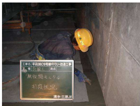
写真-24 無収縮モルタル打設
