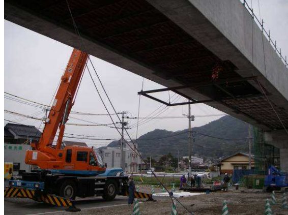
写真-16 下弦材撤去
