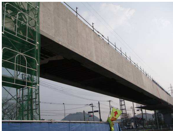
写真-14 セグメント桁組立完了
