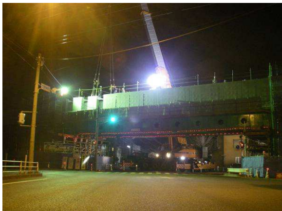
写真-9 セグメント桁引き寄せ
