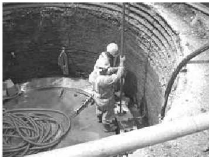
写真-4 軸方向鉄筋挿入状況
