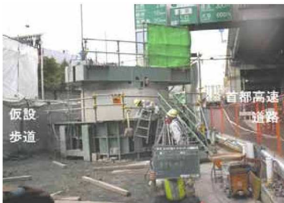
写真-1 近接状況写真
