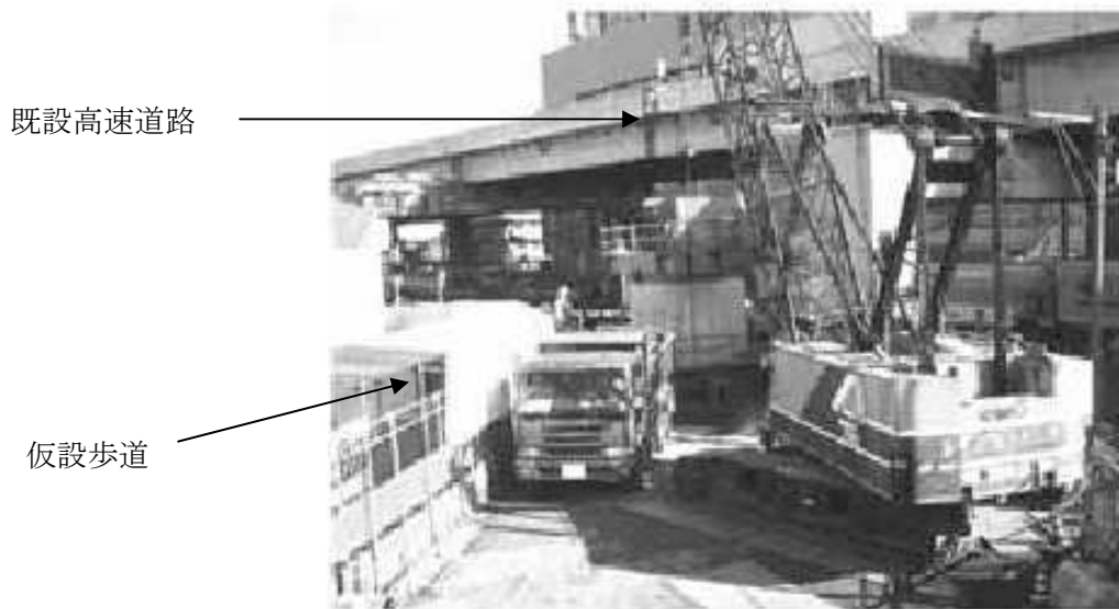
写真-2 作業状況 (掘削・積み込み)
