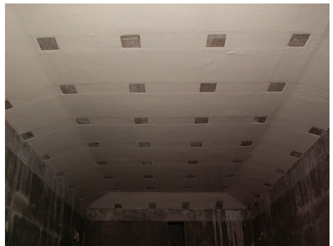
写真-2 炭素繊維シート接着工法による床版補強
