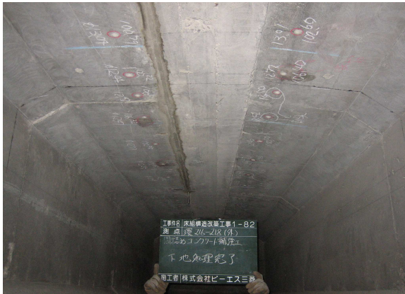
写真-1 鋼板設置前の状況
