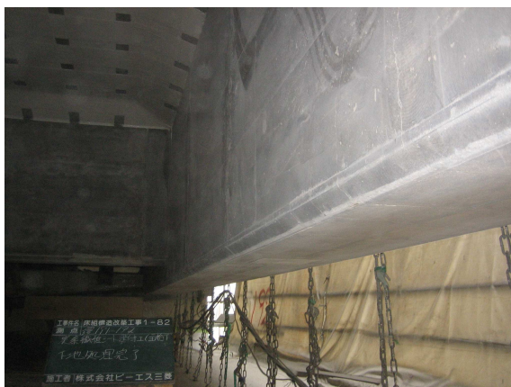
写真-3 シート接着前の状況
