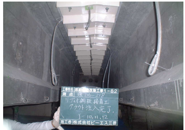
写真-2 鋼板設置後の状況
