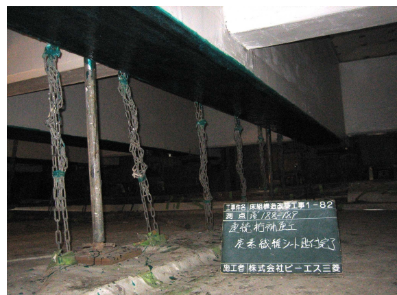
写真-4 シート接着後の状況
