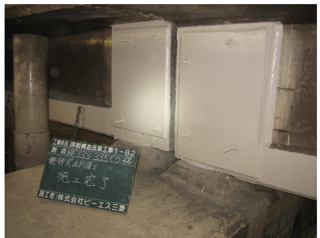
写真-5 端部横桁の突出防護工
