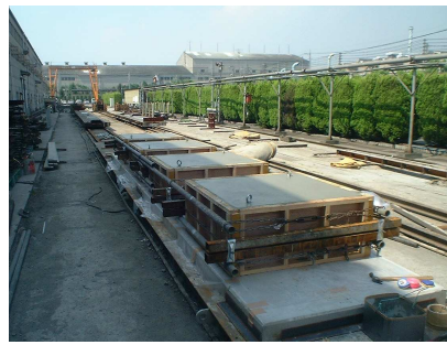
写真-2 供試体製作状況
