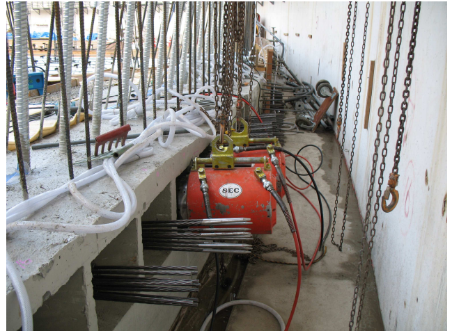
写真-1 仮緊張実施状況
