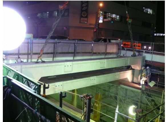
写真-2 PCa 頂版架設状況
