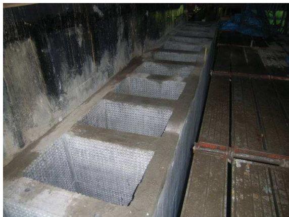
写真-7 ソケット部完成状況
