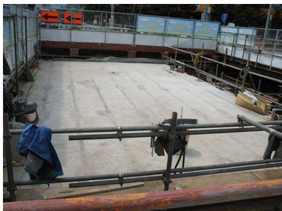
写真-9 上床版完成状況
