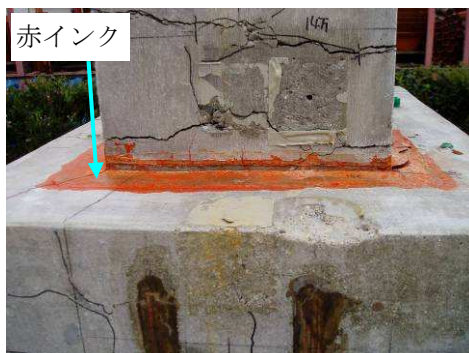
写真-4 ソケット部付着健全度の確認
