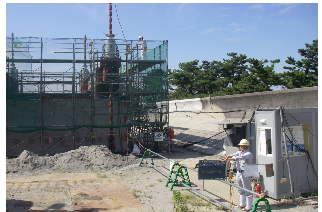
写真-2 圧入沈設状況
