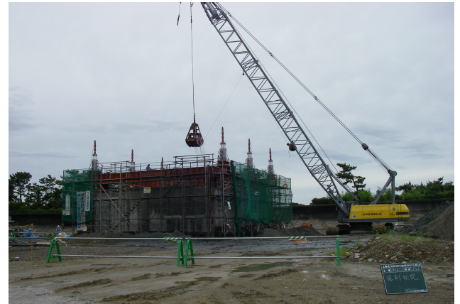
写真-1 掘削状況
