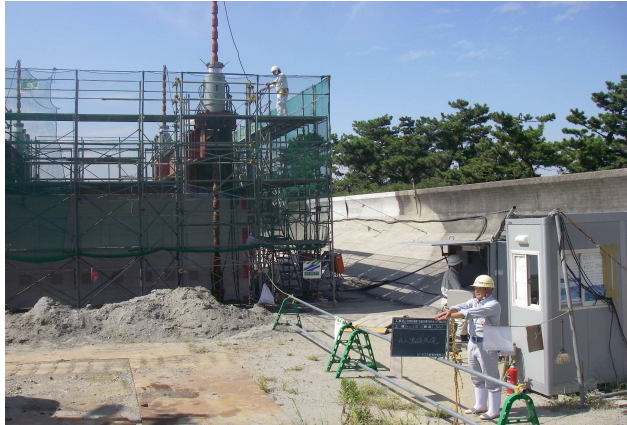
写真-6 圧入沈設状況
