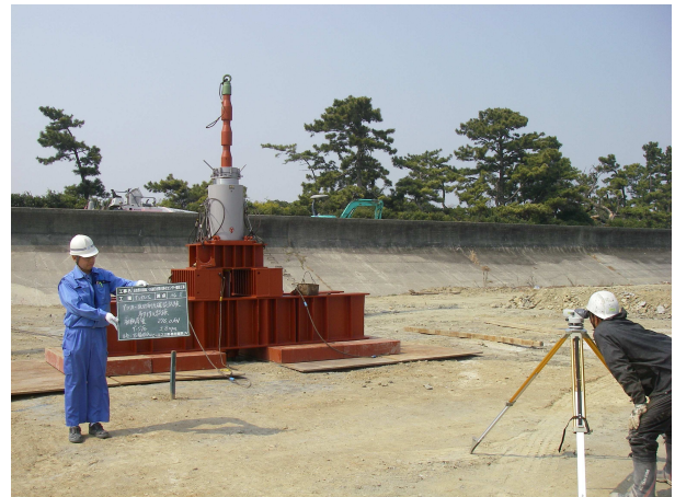
写真-1 耐力確認試験状況
