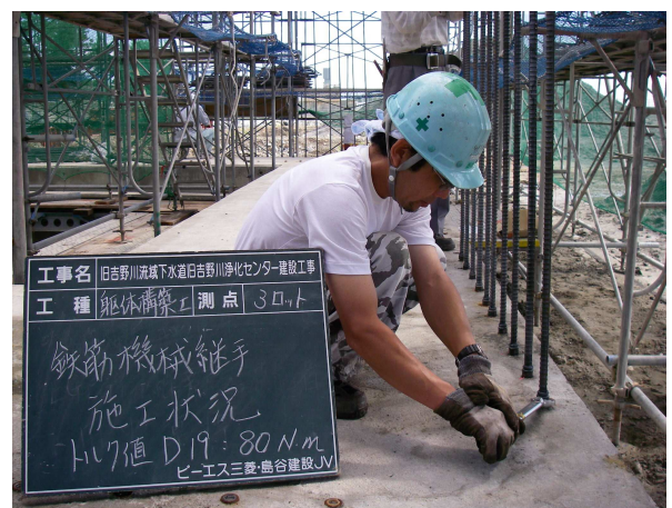
写真-3 鉄筋工（機械継手施工状況）
