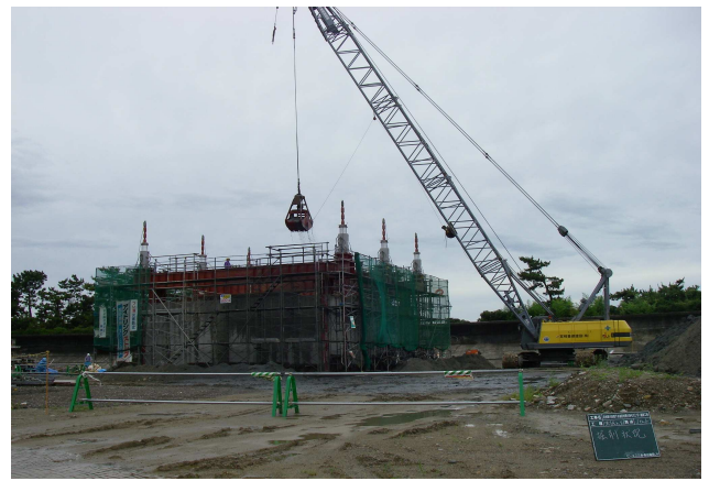
写真-4 掘削状況①
