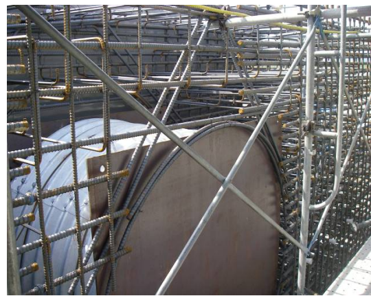
写真-1 円筒型枠設置状況
