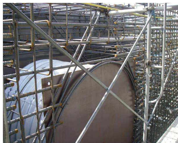
写真-1 円筒型枠設置状況
