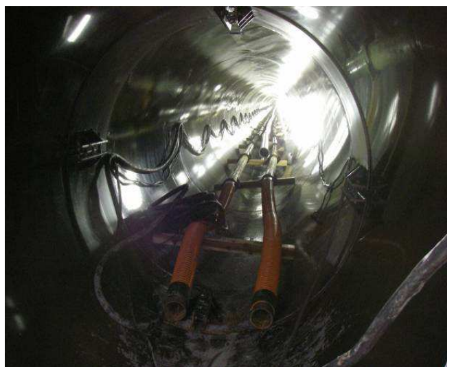
写真-4 推進内部状況
