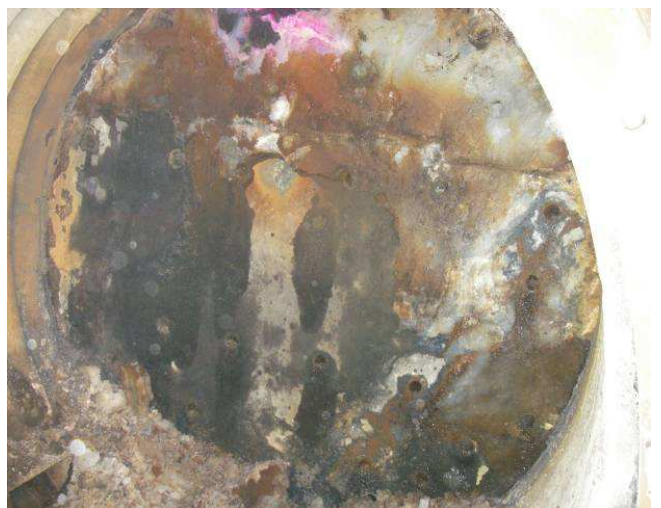
写真-3 地山の状況
