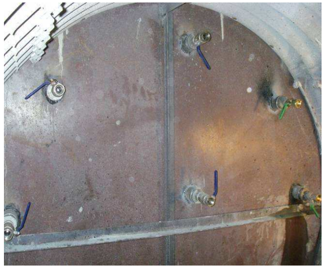
写真-2 バルブ設置状況
