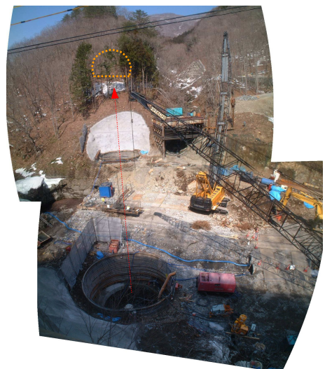
写真-4 終点側坑口
