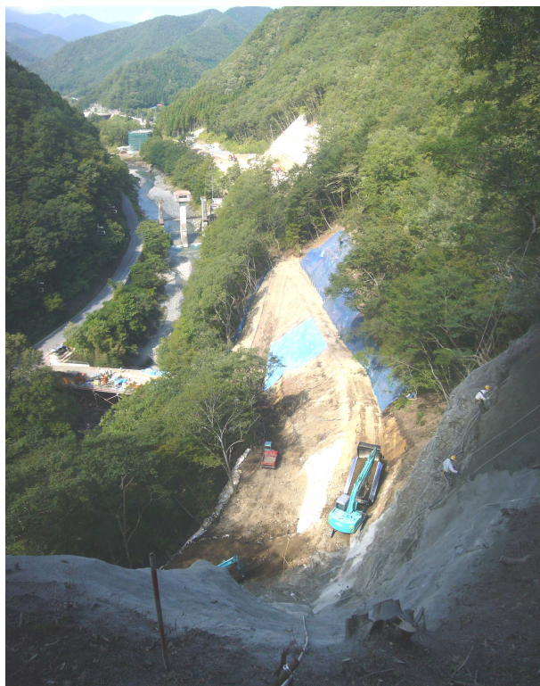
写真-5 起点側坑口 (終点側から望む)
