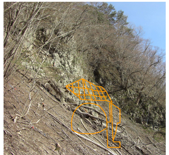
写真－1 起点側坑口
