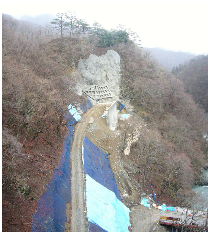
写真-6 起点側坑口 (起点側から望む)
