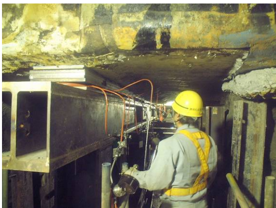
写真-1 プレロード施工状況
