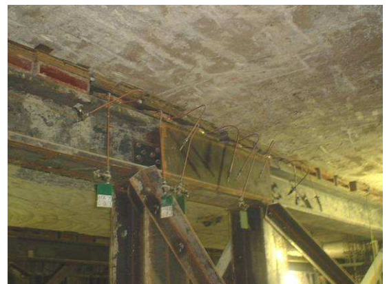
写真-4 樹脂置換後ジャッキ状況
