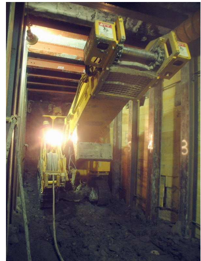
写真-2 掘削中のシャフローダー
