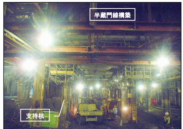
写真-1 アンダーピニング施工完了状況
