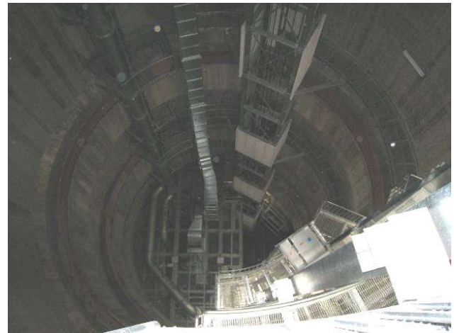
写真-1 既設発進立坑着工前（深度45m） （供用開始された重要設備が設置されている）
