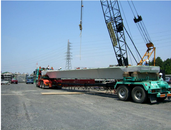
写真-2 部材の運搬
