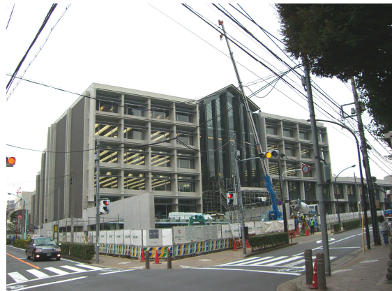
写真-7 外観写真
