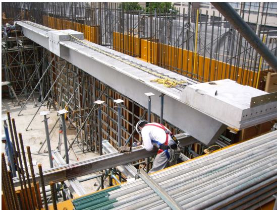
写真-4 架設状況
