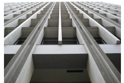
写真-2 薄型 PCaPC 柱部材
