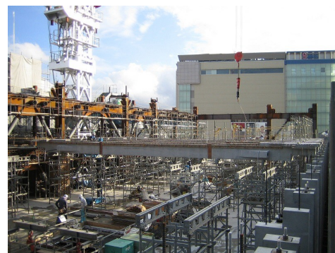
写真-3 梁部材架設状況
