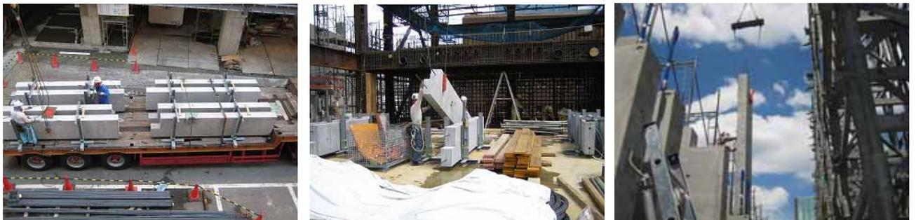
写真 - 9 PC2 柱 搬入・建起し・揚重状況
