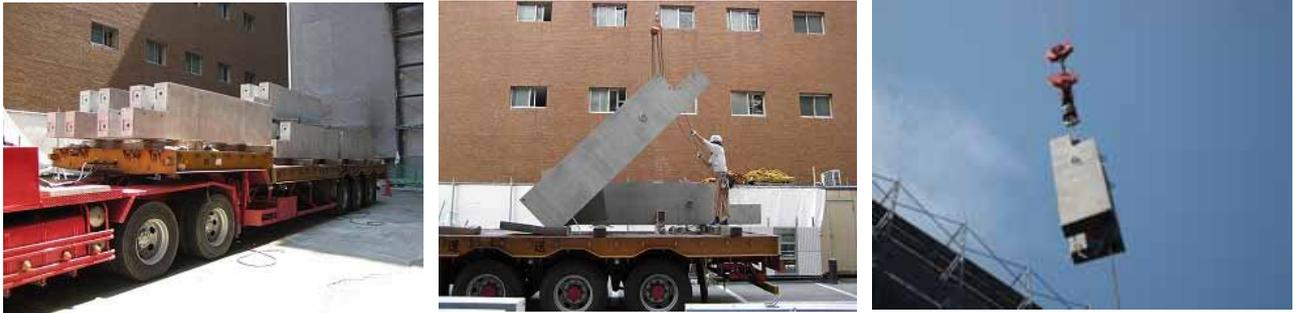
写真 - 8 PC1 柱 搬入・建起し・揚重状況
