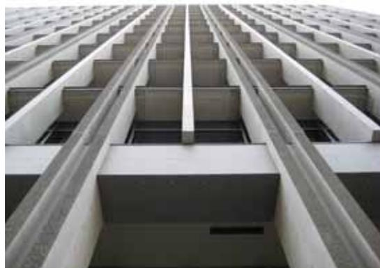
写真 - 2 薄型 PCaPC 柱
