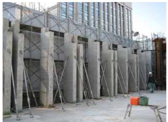
写真 - 10 柱部材据付状況
