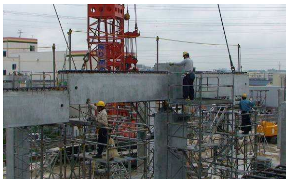
写真－12 PC レンコン部材施工状況－2
