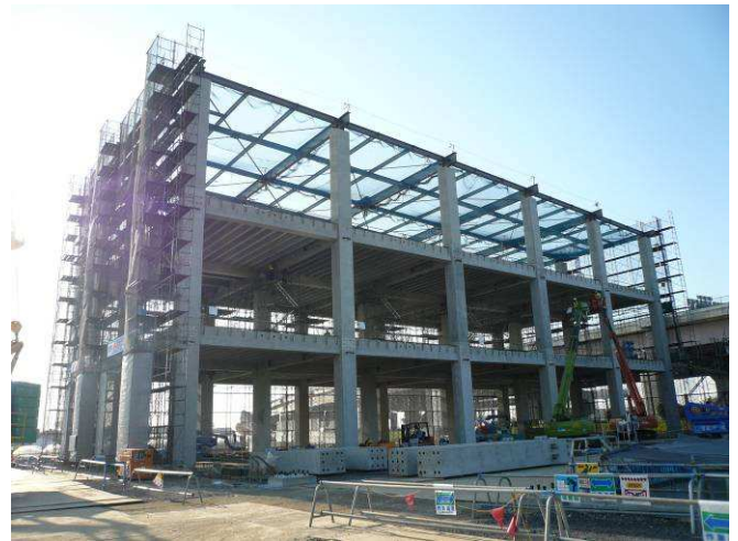
写真-2 架構の施工状況
