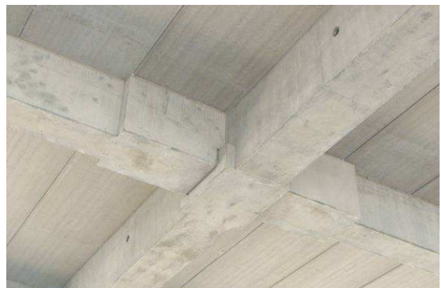
写真-9 PCaPC 小梁支承部
