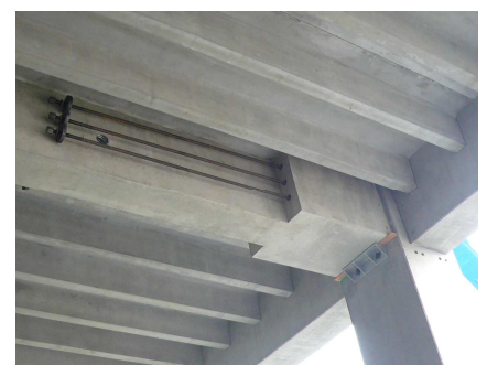
写真-5 横締めPC鋼棒
