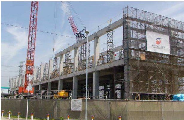
写真-7 架構状況
