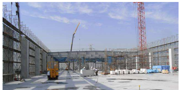
写真-8 鉄骨屋根施工状況
