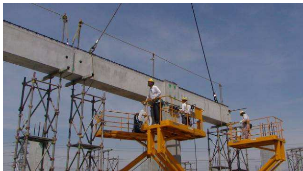
写真－11 PC レンコン部材施工状況－1
