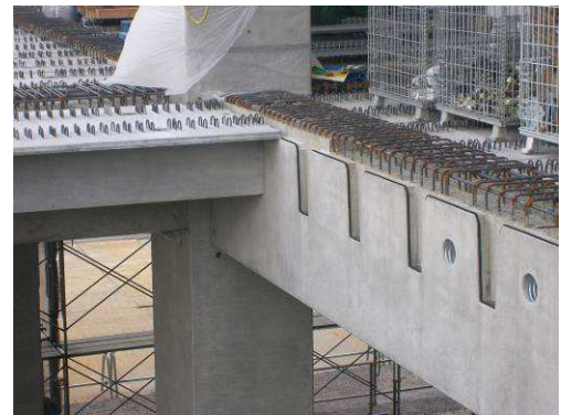
写真-4 DT版支承部
