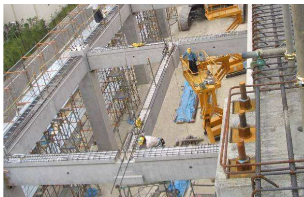
写真-10 PCaPC 小梁架設状況
