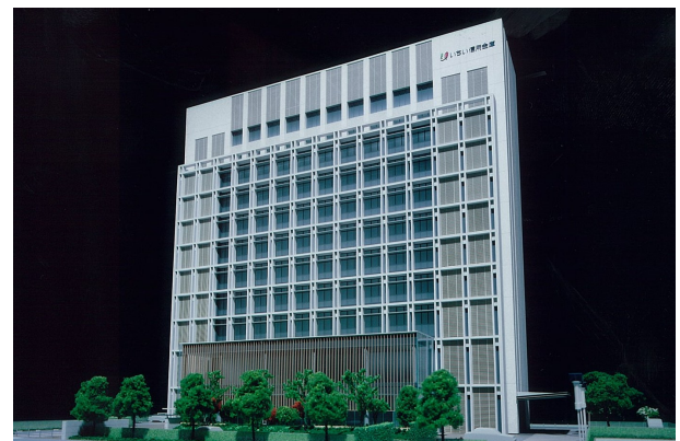
図—1 いちい信用金庫新本店完成予想パース (資料提供：日建・垣見設計監理共同企業体)
