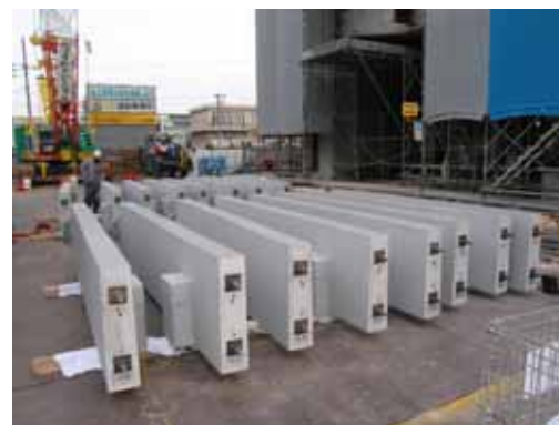
写真 - 13 PCaPC 造細柱の仮置き状況
