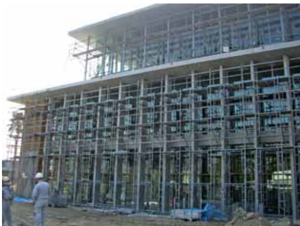
写真-2 2層1節柱の支保工設置状況
