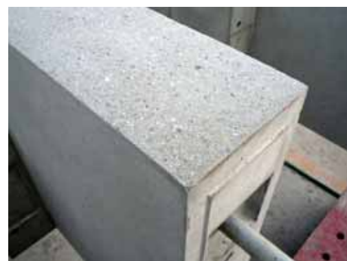
写真 - 9 細柱の削り出し仕上げ後 の状況
