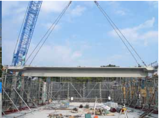
写真 - 15 ST 板架設状況
