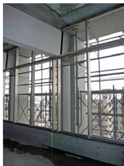
写真 - 18 事務所内部状況
