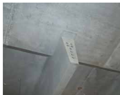
写真 - 7 プレテンション PC 鋼材 端部処理後の状況
