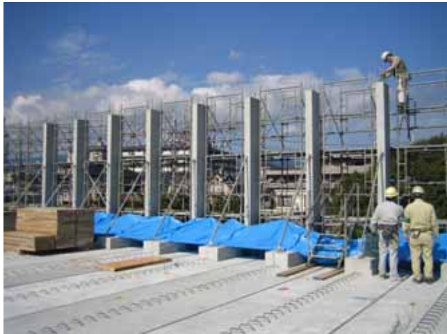
写真 - 14 PCaPC 造細柱建方状況
