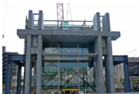
写真 - 16 モックアップ工事
