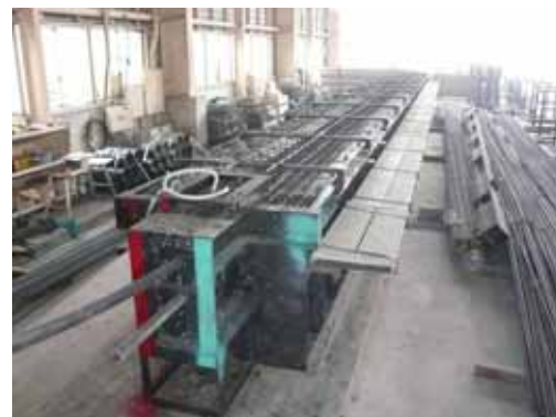
写真 - 12 ST 板の製作状況
