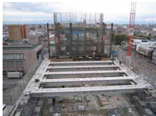
写真 - 17 ST 板架設状況
