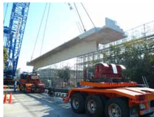
写真 - 11 ST 板の積込状況
