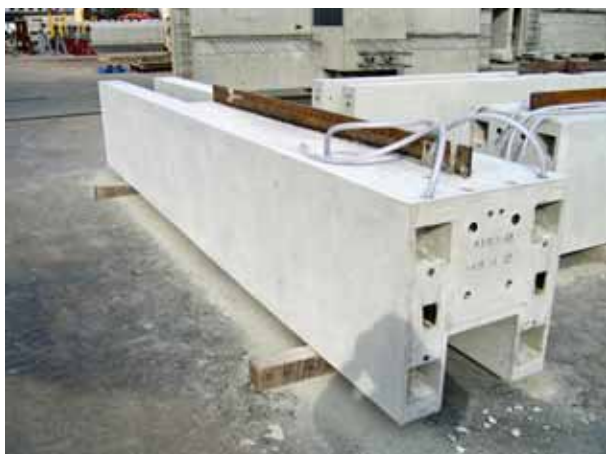
写真 - 4 M3 階 PCa 柱の仮置き状況
