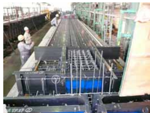
写真 - 10 ST 板の製作状況
