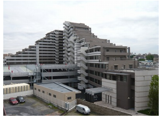
写真-1 建物外観
