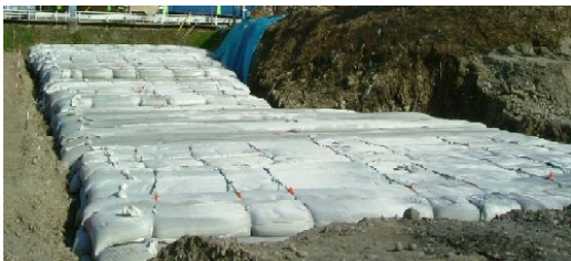
写真-2 脱水養生状況
