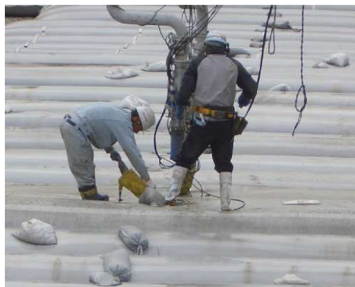
写真-9 充填状況
