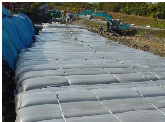
写真-10 袋体積み上げ状況
