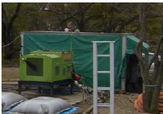
写真－6 泥土計測装置・泥土圧送ポンプ
