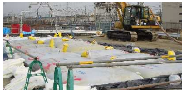
写真－2 有害物質を含んだ底質の脱水・減量化
