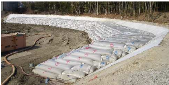
写真－1 浚渫土の築堤盛土材への利用状況
