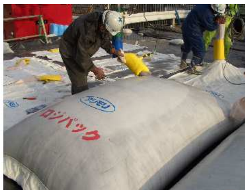
写真-7 ダイオキシン類汚染土充填状況
