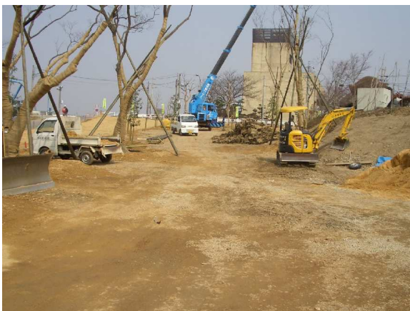
写真-13 袋詰脱水処理土覆土・植栽状況
