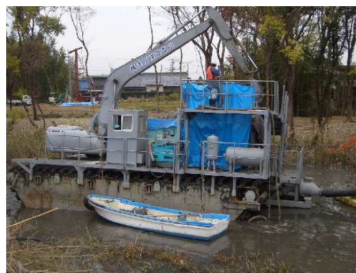
写真-4 浚渫小型圧送機作業状況
