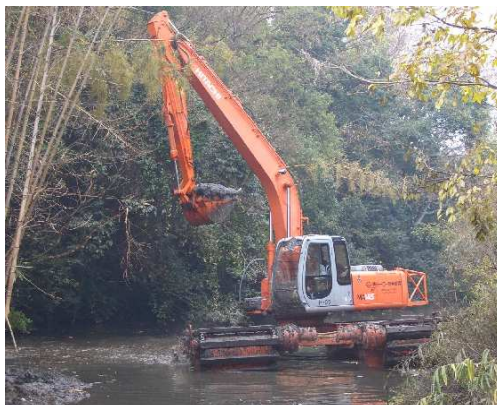
写真-3 泥上掘削機作業状況
