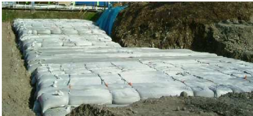
写真-12 脱水養生40日後
