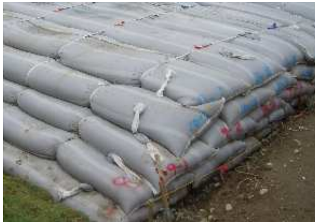
写真-11 施工終了直後
