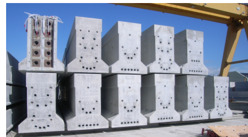
写真-1 セグメント仮置き状況
