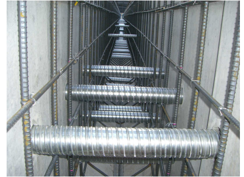
写真-15 桁間鉄筋・シース組立完
