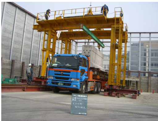
写真-5 セグメント取り降し状況
