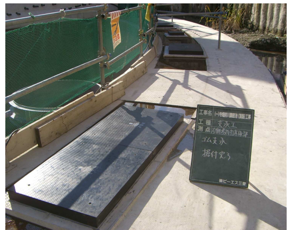
写真-4 支承⑩据付完了
