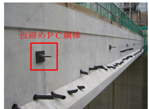
写真-16 仮締めPC鋼棒設置
