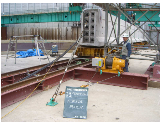
写真-7 主桁P C鋼材挿入状況
