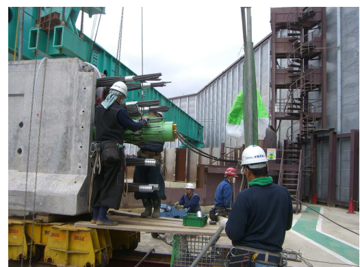
写真-8 主桁P C鋼材緊張状況
