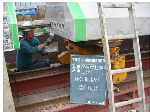
写真-6 接合部接着剤塗布状況
