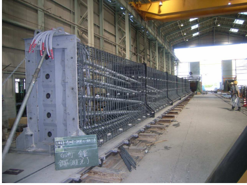
写真-2 G12桁鉄筋組立完了
