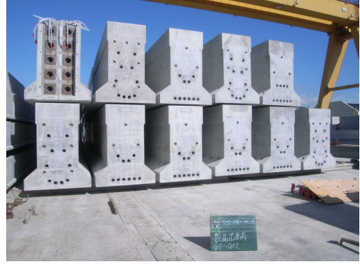
写真-3 セグメント仮置き状況
