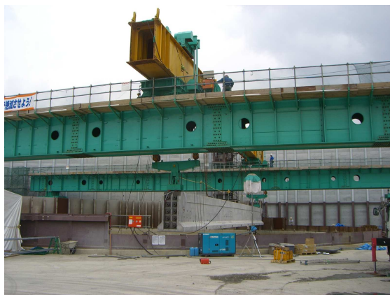
写真-11 桁架設状況 (横移動作業中)
