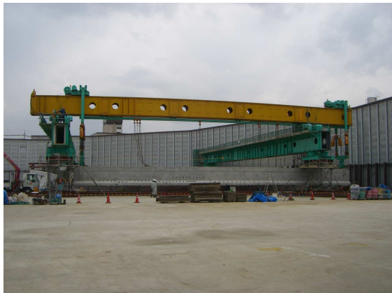
写真-10 桁架設状況 (吊り込み作業中)
