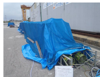
写真-1 ミスト養生状況
