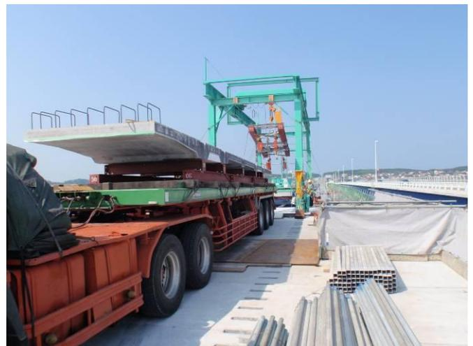
写真-4 運搬架台使用状況
