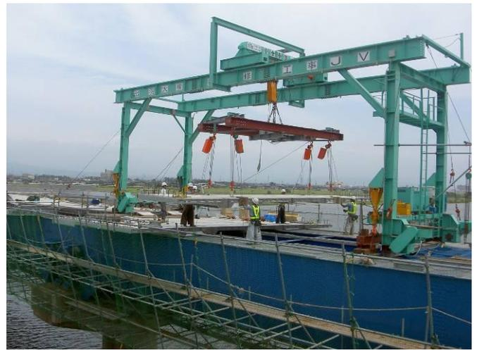
写真-3 吊り治具使用状況
