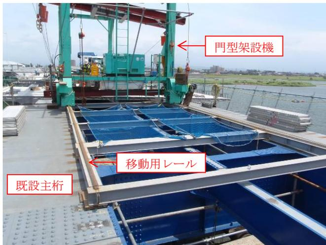
写真-2 門型架設機移動・設置状況
