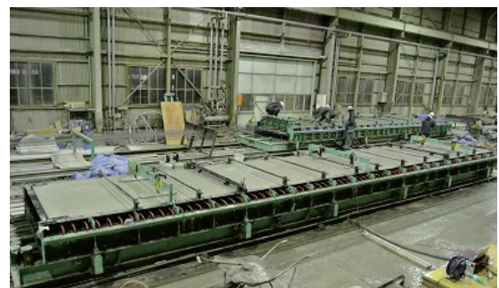
写真-1 試験部材の製造状況
