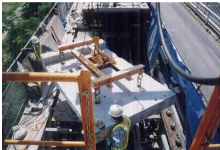
床版取り替え幅員拡幅化
