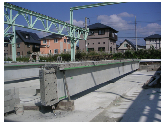
写真-4 完成した主桁
