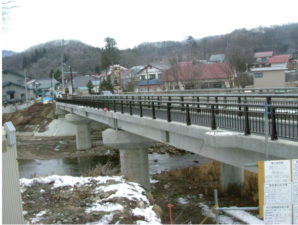
写真-1 完成した井桁歩道橋
