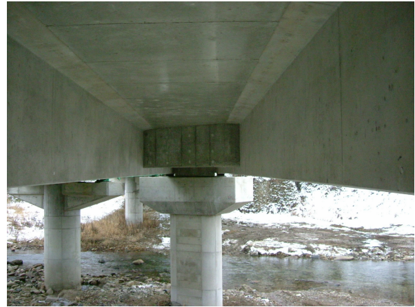
写真-2 井桁歩道橋の間詰め床版
