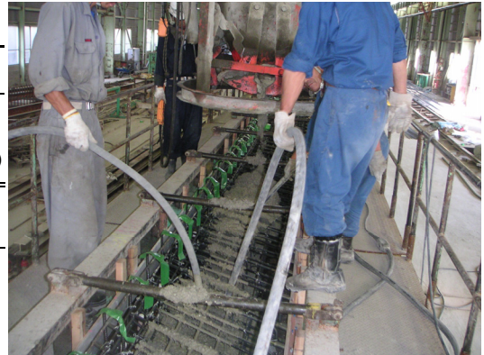
写真-3 打込み状況
