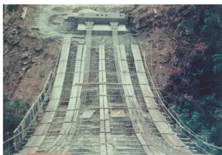
1次ケーブルの張渡し
