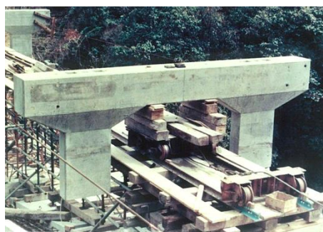
鉛直材の引出し
