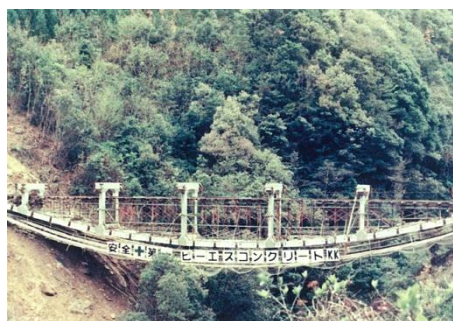
鉛直材の架設完了
