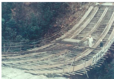
プレキャスト部材の引出し架設
