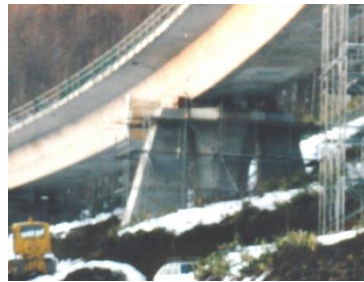
P7橋脚の横方向制御補強
