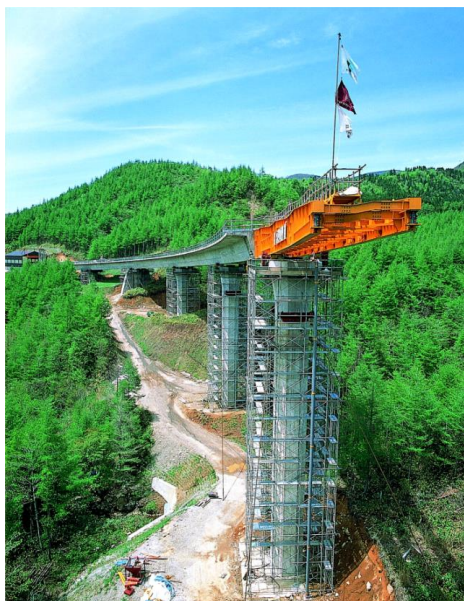
押し出し架設状況
