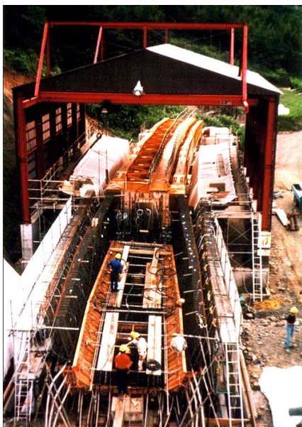
主桁製作設備
