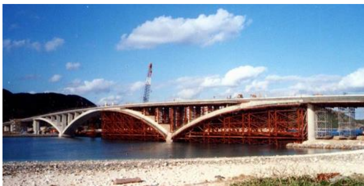
支保工による架設(P5系)
