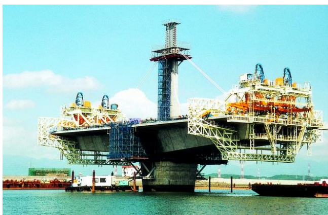
セグメントの架設装置
