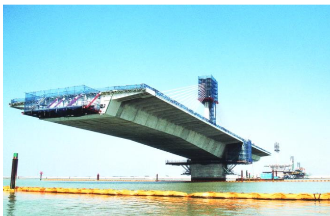
セグメントの架設終了
