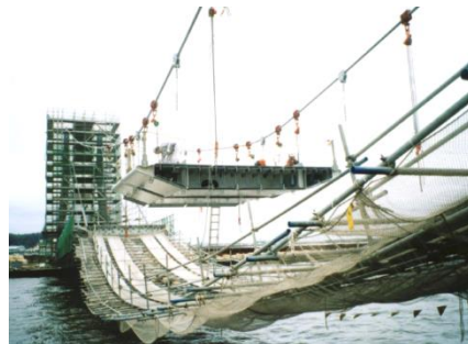
鋼桁の架設
