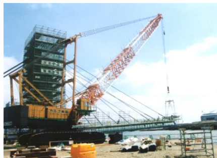
コンクリート桁の架設
