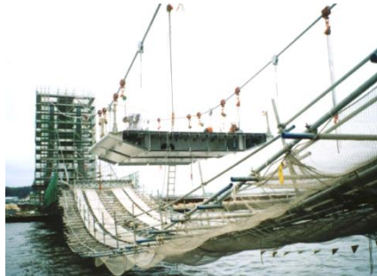
鋼桁の架設
