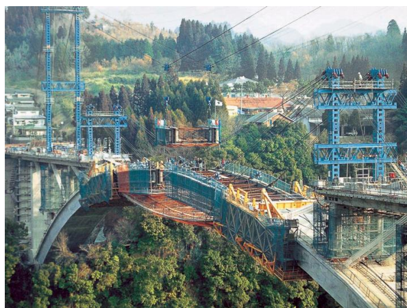
メラン材(鋼管)の閉合
