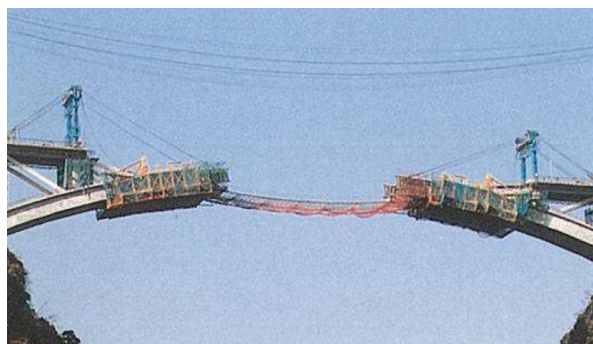
斜吊りによるメラン材の架設
