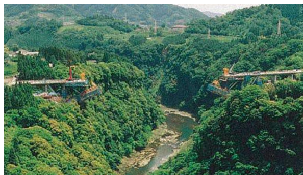
トラス工法による張出し施工
