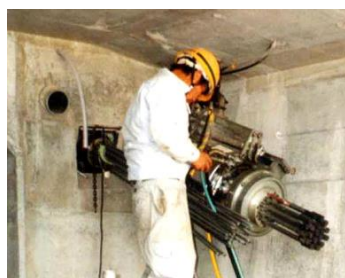
外ケーブルの緊張
