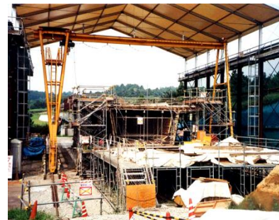
主桁製作設備
