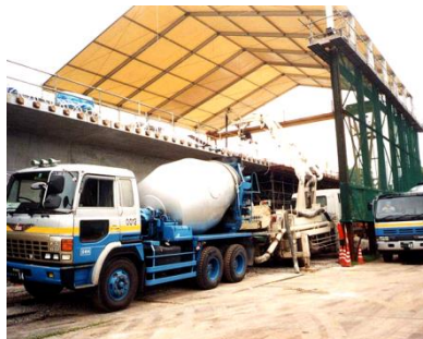
コンクリート打設
