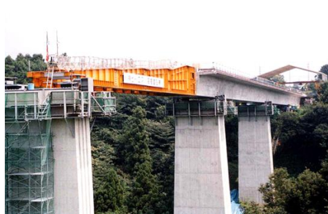
押し架設状況
