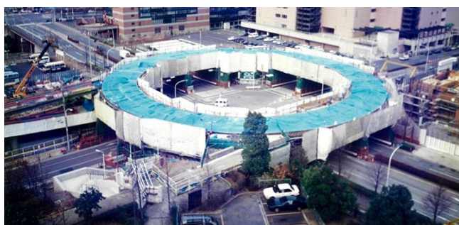
施工中(支保工により一括打設された)
