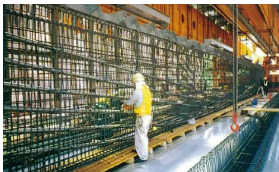
鉄筋PCケーブル組立
