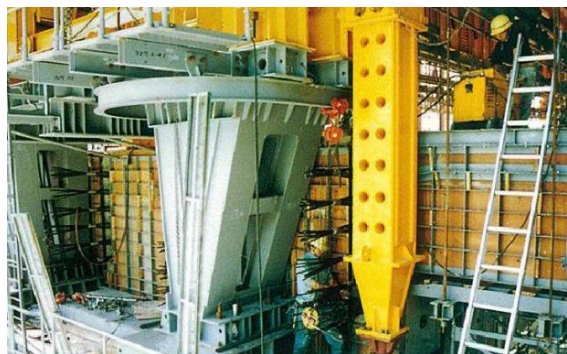
支保工の前方受架台
