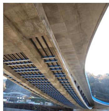
下面(1次ケーブル・サドル)
