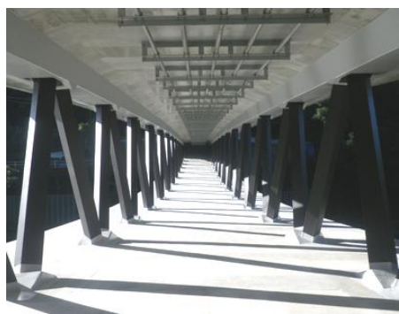
桁内部と角鋼管の斜材
