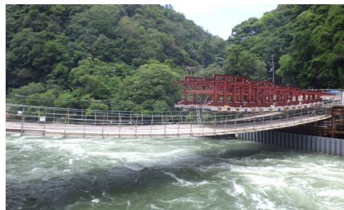
1次ケーブルを利用した架設
