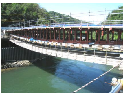
内部支保工の設置
