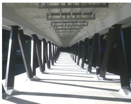
桁内部と角鋼管の斜材
