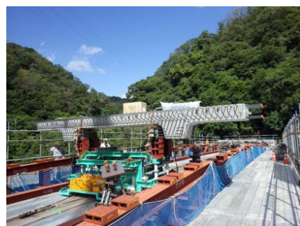
上床版の架設
