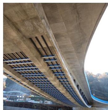
下面(1次ケーブル・サドル)
