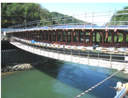
内部支保工の設置
