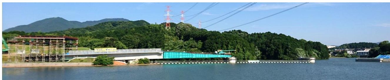
押し出し架設状況 (最初の橋脚に手延べ桁の先端が到達)
