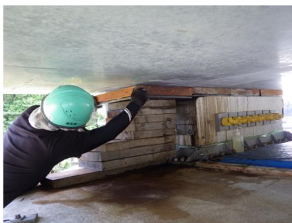
押し出し状況(すべり支承部)
