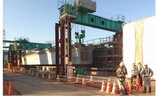
主桁製作設備
