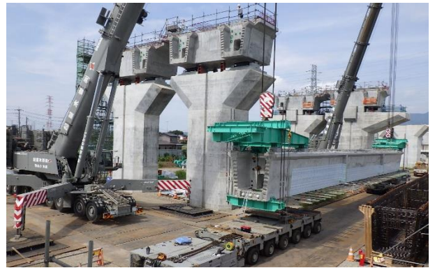
セッティングビームを使用した架設状況
