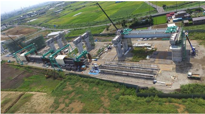
主桁製作ヤードと架設状況
